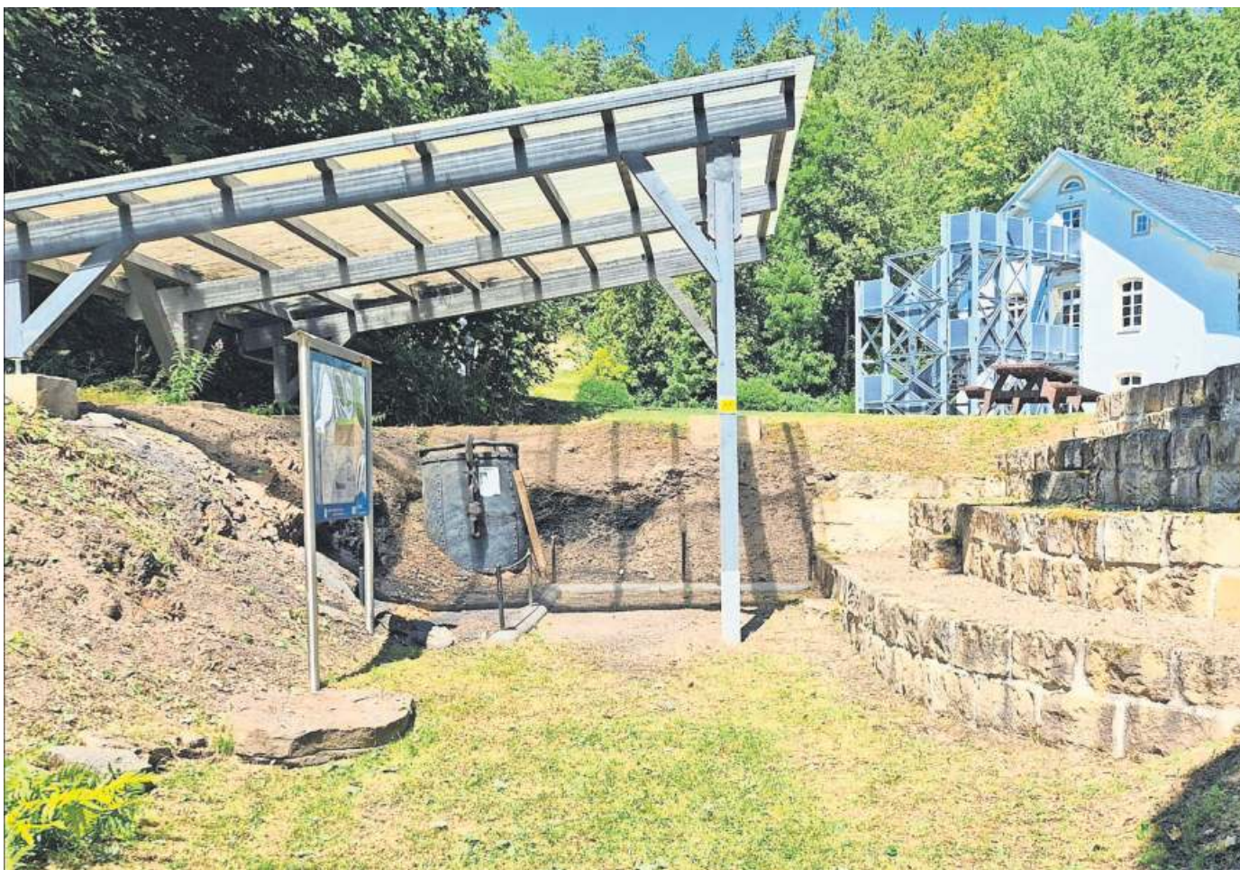
Das Geotop „Stockheimer Steinkohle“ zwischen Rentei und Bauhof auf dem ehemaligen Gelände des Stockheimer Bergwerks St. Katharina.
