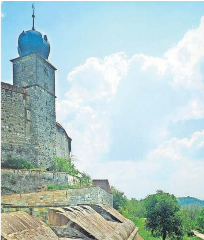
Am Untergeschoss des Blauen Turmes der Veste finden sich älteste Mauern der Burg.
