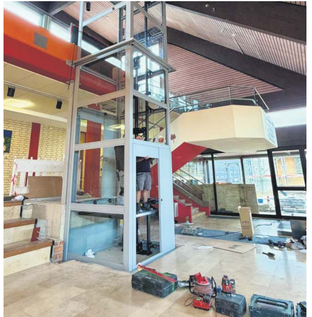
Der neue Stahl-Glas-Schacht für die Hebeanlage in der großen Aula der Johann-Gemmer-Grundschule ist bereits errichtet. Die barrierefreie Erschließung der drei Ebenen soll damit schon zu Beginn des neuen Schuljahres möglich werden. Foto: Gemeinde Ahorn
