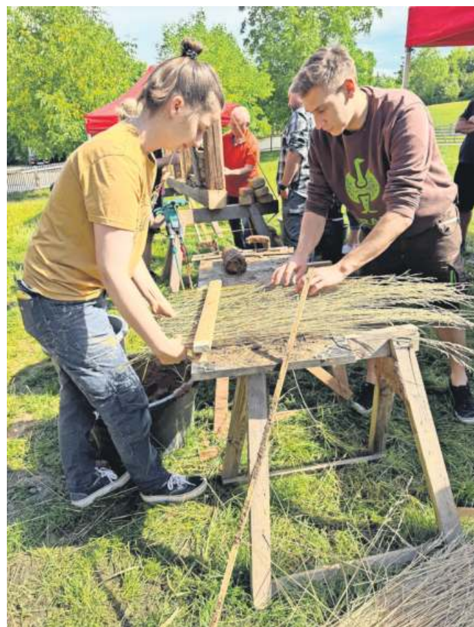
Vorbereitung zur Lehmwickelherstellung.
