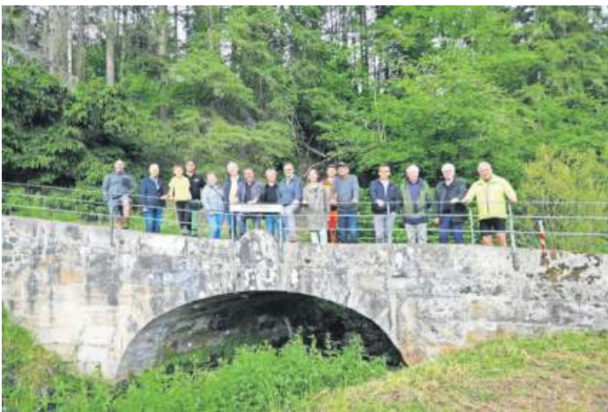
Auf der Bamberger Brücke versammelten sich alle Ehrengäste und Helfer, die bei den Arbeiten irgendwie beteiligt waren. Initiator Björn Stumpf siebter von links.
