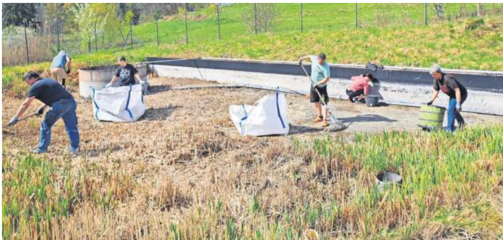
Ehrenamtlicher Arbeitseinsatz: Reinigung Regenerationsbecken vor zwei Wochen.
