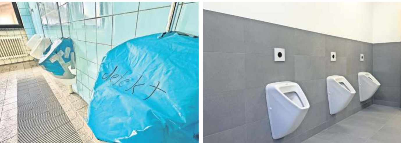
Alte Toilettenanlagen. Fotos: Gemeinde Ahorn Neue. Toilettenanlagen
