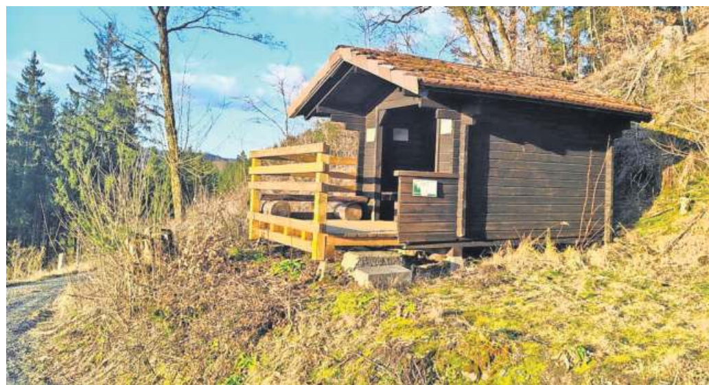
Auf der sanierten Terrasse wurde eine Sitzbank von Caro Hollendonner und dem Bauhof aufgestellt. Gespendet wurde sie von den Bayerischen Staatsforsten. Fotos: Caro Hollendonner
