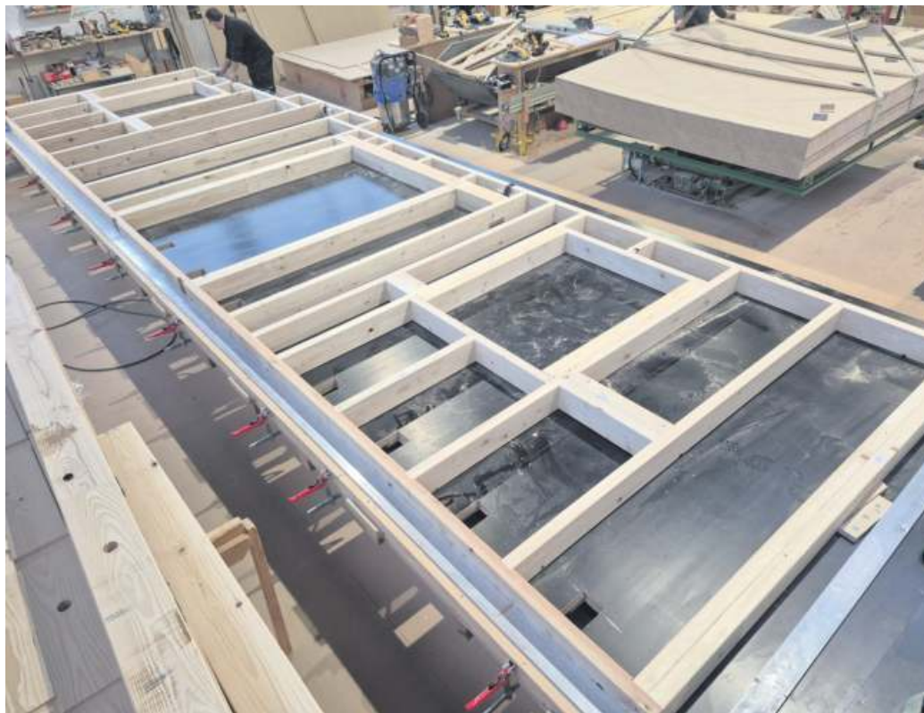
Blick in die Produktion bei Adlerhaus. Die hochwertigen Holzfertighäuser bestehen aus regionalem, nachhaltig angebautem Fichtenholz. Die Wände werden in Holzrahmenbauweise komplett im Werk Nordhalben vorgefertigt.
