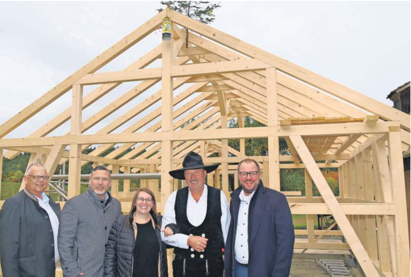
Erster Schritt geschafft: Martin Stingl, Martin Finzel, Yvonne Spindler, Peter Kraft und Sebastian Straubel (von links) freuen sich beim Richtfest für das neue Lagergebäude auf dem Gelände der „Alten Schäferei“ in Ahorn. Foto: Landratsamt Coburg / Berthold Köhler
